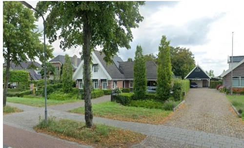
Bestaande lintbebouwing Noorderdracht
